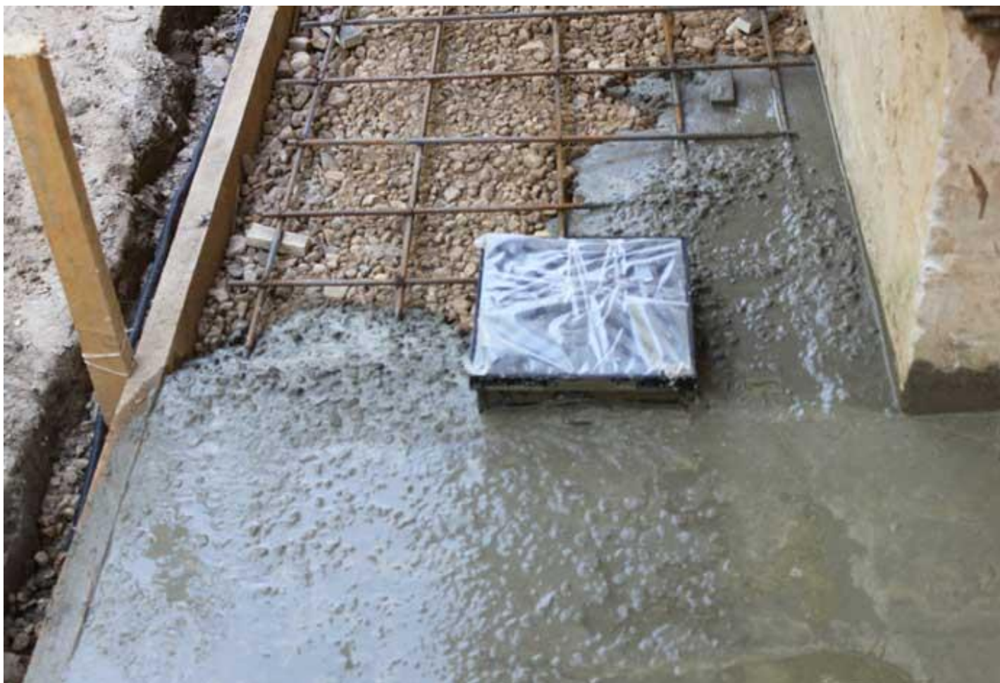
Подготовка бетонного основания для мощения тротуарной плиткой.
