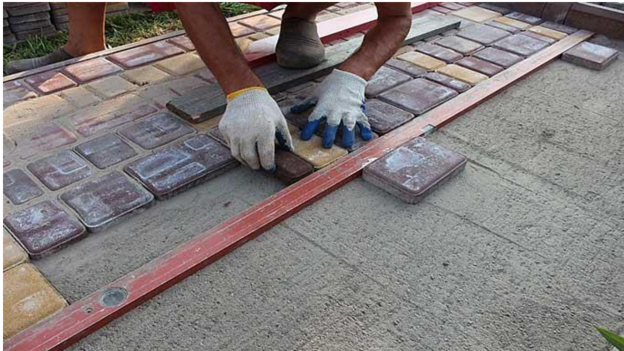
Мощение тротуарной плиткой на подготовленном бетонное основание.
